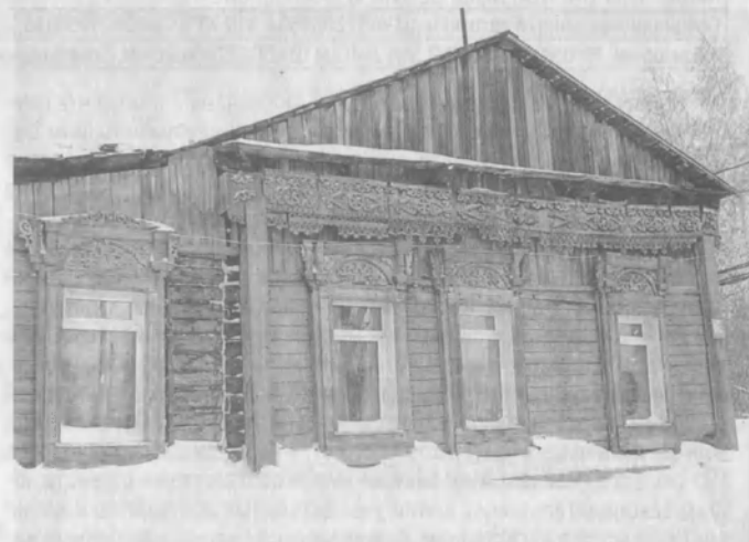
■ Дом с деревянной резьбой на проспекте Пролетарском.
